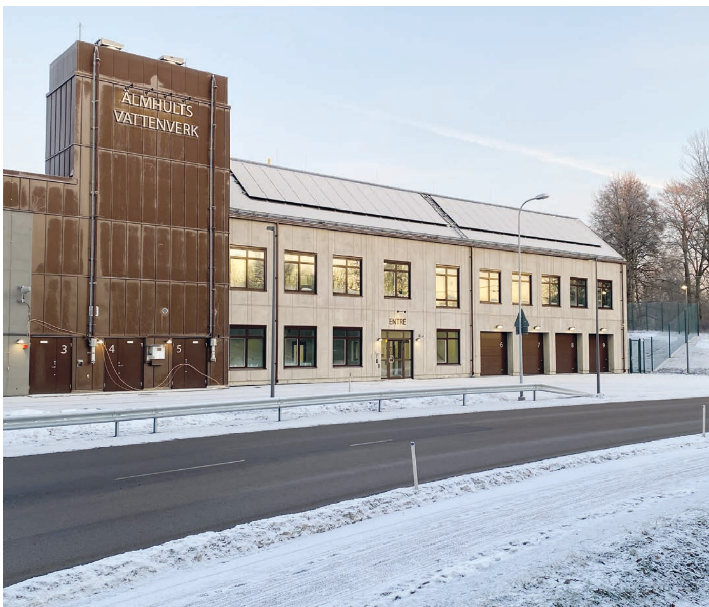
Älmhults nya vattenverk
